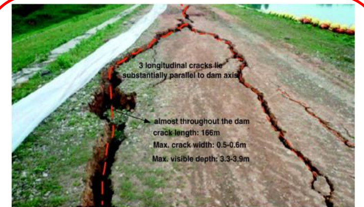
(d) Dam crack by seismic Load
